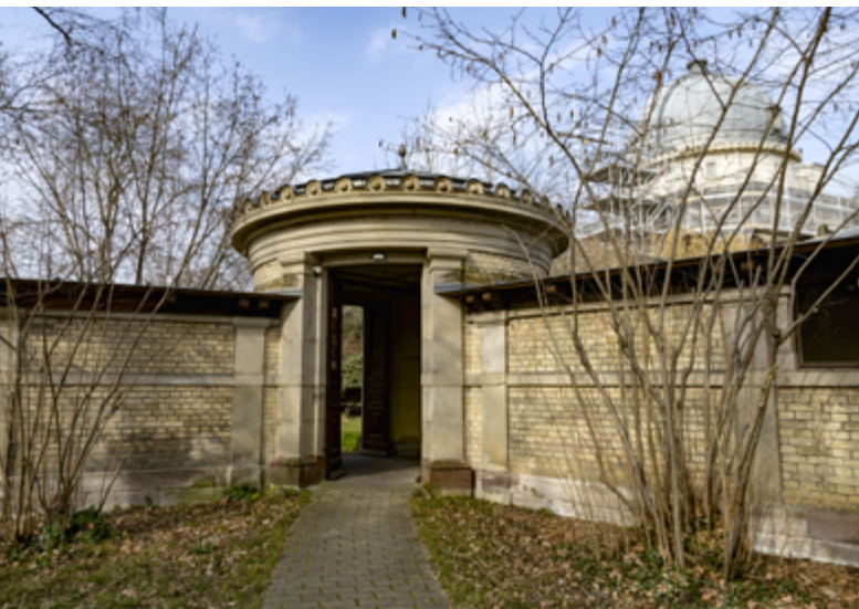
Point de jonction central reliant les trois corridors.
