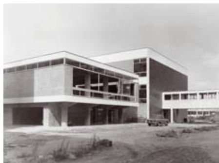
Faculté de lettres et de sciences humaines (architecte Pierre Vivien, Paris) [Photo non datée et non signée]. Source : Rectorat.
