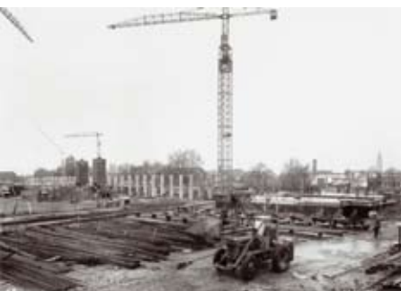
Chantier de l'Institut et école nationale supérieure de chimie. Photo de Charles Heitz datée du 23 novembre 1960. Source : Rectorat.
