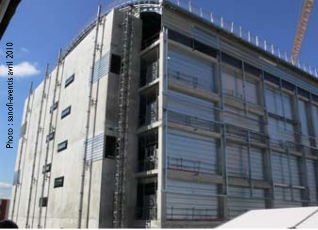
Les nouveaux bâtiments de production en construction à Vitry-sur-Seine.
